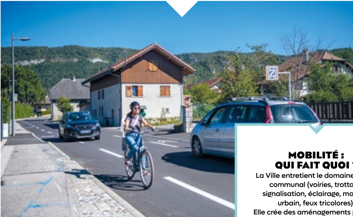
▲ Un chaussidou (chaussée à voie centrale banalisée), un aménagement qui facilite la cohabitation entre tous les usagers de la route quand il n'y a pas la place pour créer des pistes ou bandes cyclables, sur des voiries à faible trafic.
